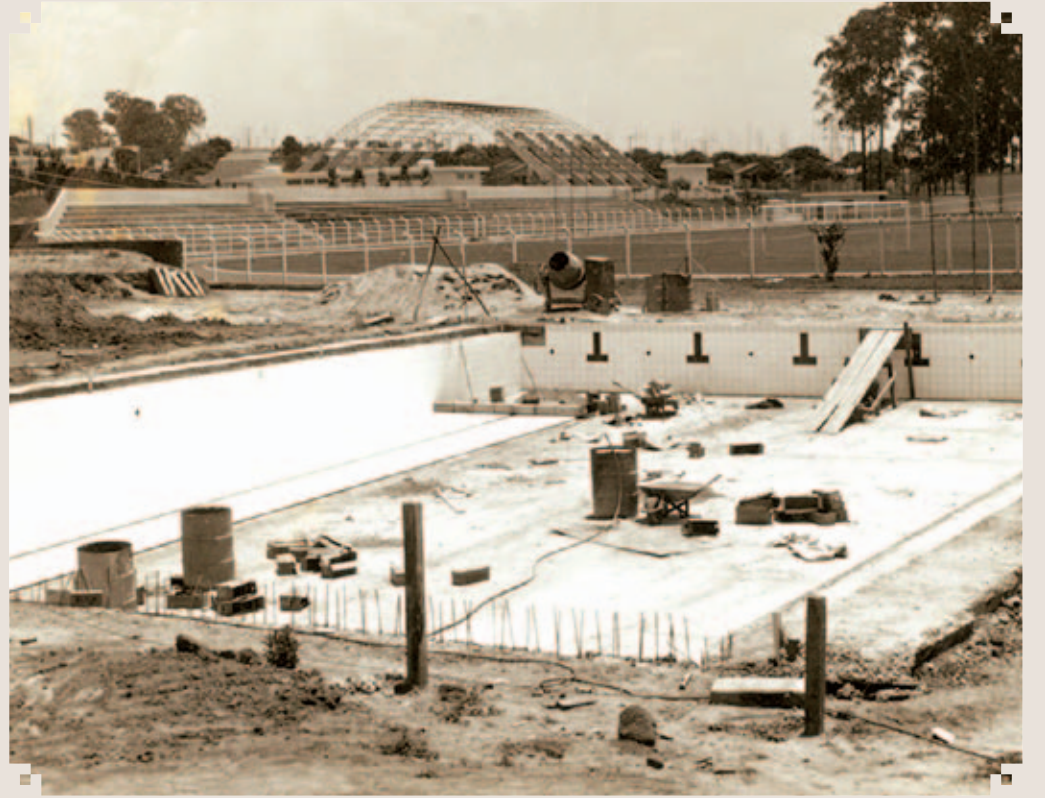
Registro fotográfico do Centro Esportivo “Vereador José Pereira”, ainda em fase de construção. Em primeiro plano, a piscina; ao fundo, o campo de futebol e o Ginásio. A construção começou oficialmente no dia 8 de novembro de 1973 e a obra foi inaugurada solenemente no dia 26 de julho de 1974.
