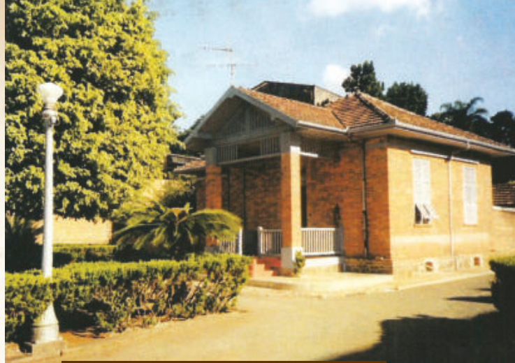
Fotos acima: Subestação de Energia de Sumaré
