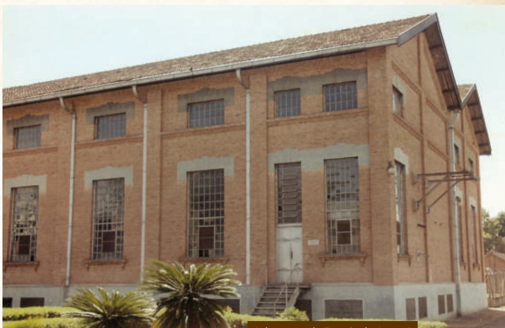
Subestação de Energia de Sumaré
