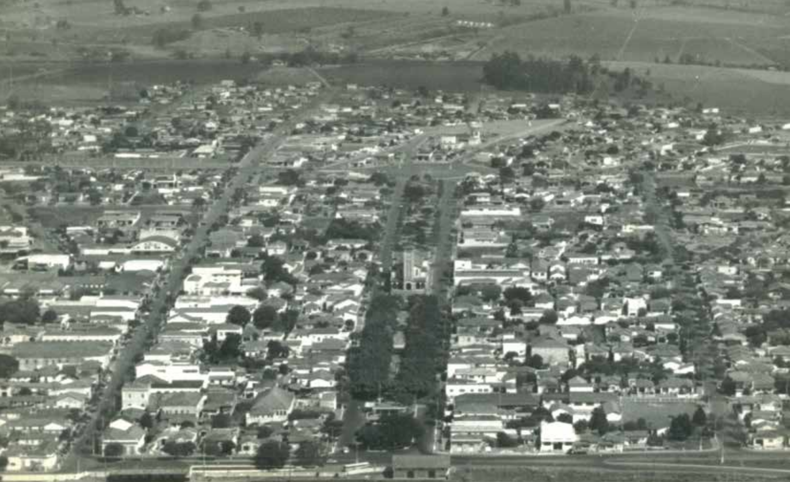
Vista aérea - Sumaré em 1965
