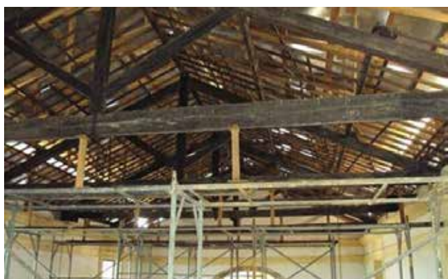
Figura 03: A Igreja após o escoramento do telhado (Acervo do CECI, 2009)
