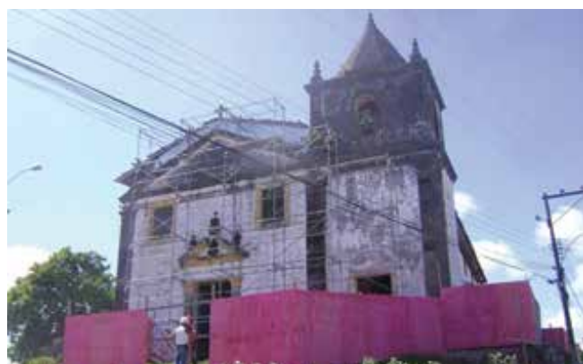
Figura 04: A Igreja antes do início do restauro (Acervo do CECI, 2011)
