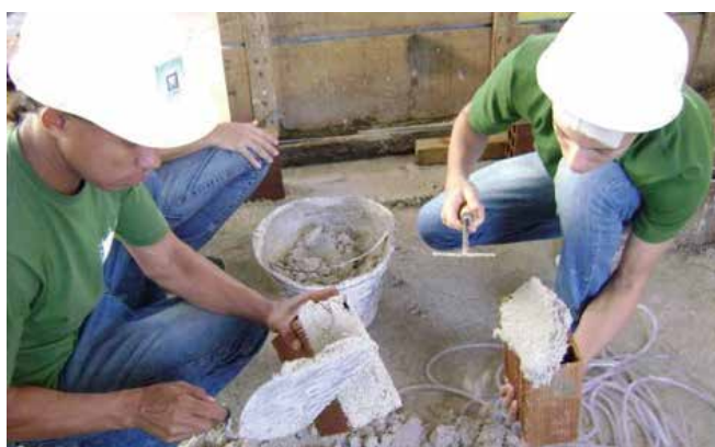
Figura 14: Módulo Específico, técnicas de elevação de alvenarias – Prática dos alunos sob orientação do mestre instrutor (Acervo CECI, 2011)
