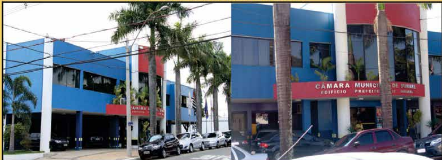
Abaixo o prédio atual após a explosão. Logo após o incidente, cuidou-se da reforma da Câmara que foi concluída no início de 2007.
