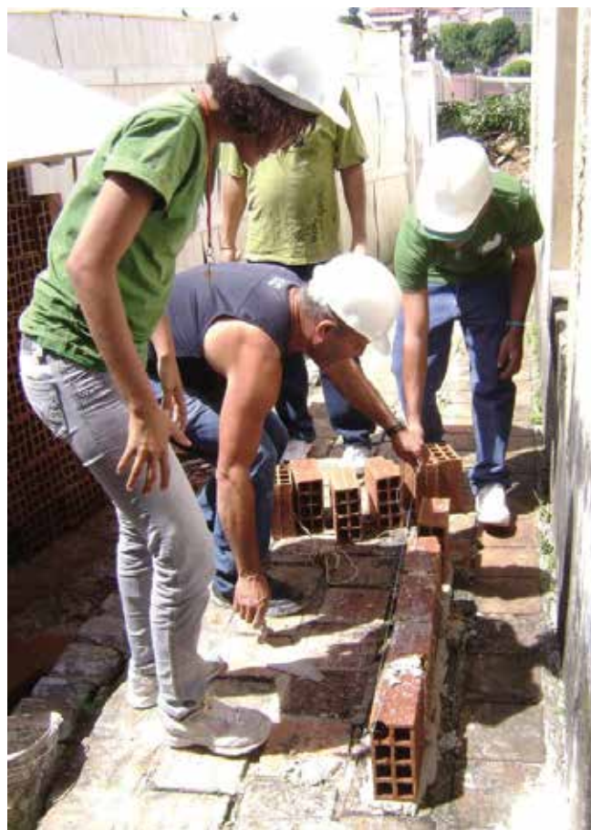
Figura 15: Módulo Específico, técnicas de elevação de alvenarias – Prática dos alunos sob orientação do mestre instrutor (Acervo CECI, 2011)
